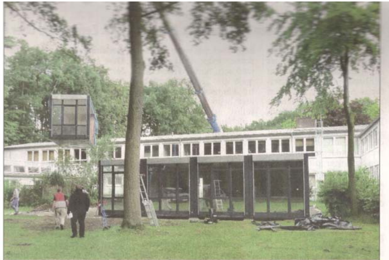
Fliegende Klassenzimmer: Per Kran werden die Unterrichts-Container über das Schulgebäude hinweg auf die Grünfläche zwischen Schule und Hausmeisterwohnung gehoben.
