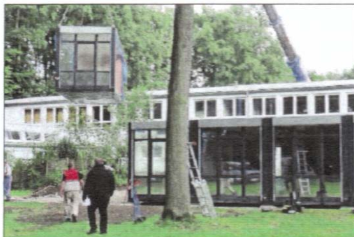
Ein Kran hievte die Container in den Innenhof der Gesamtschule, wo sie künftig als Klassenräume genutzt werden.
