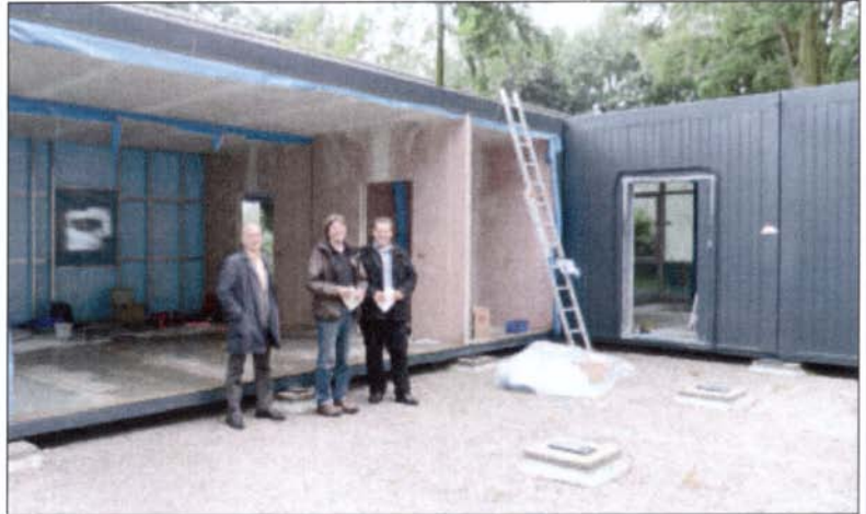
Klaus Brüggelolte und Peter Janßen vom Fachdienst Gebäudewirtschaft sowie der zuständige Bauingenieur Daniel Eckert von der Deutschen Industriebau machen sich vor Ort ein Bild von der Baustelle.
