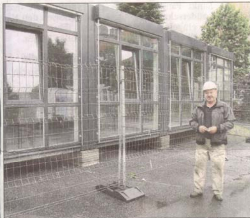
Vier Container mit Fensterfronten haben Bauleiter Hans-Jürgen Willimzik und drei Kollegen auf dem Hof der Nikolaus-Schule aufgebaut. ■ Foto: Rückert
